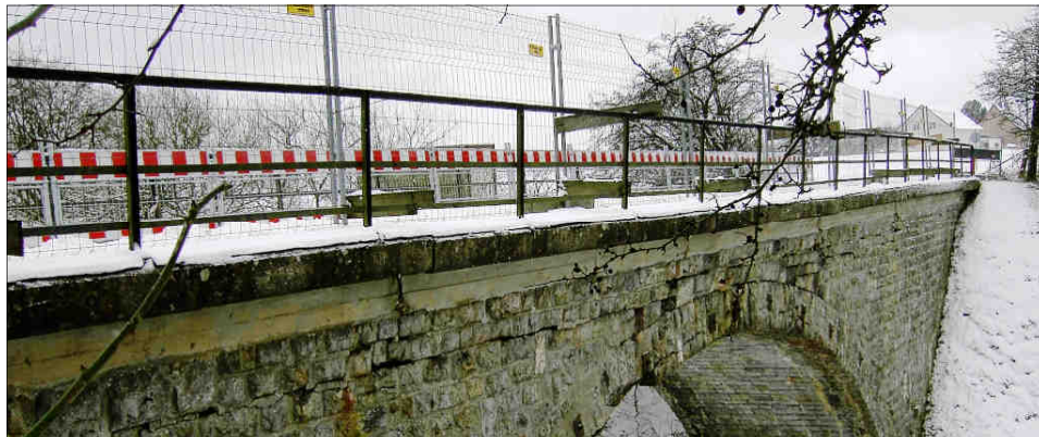
Die Schossenbrücke vor der Renovierung
