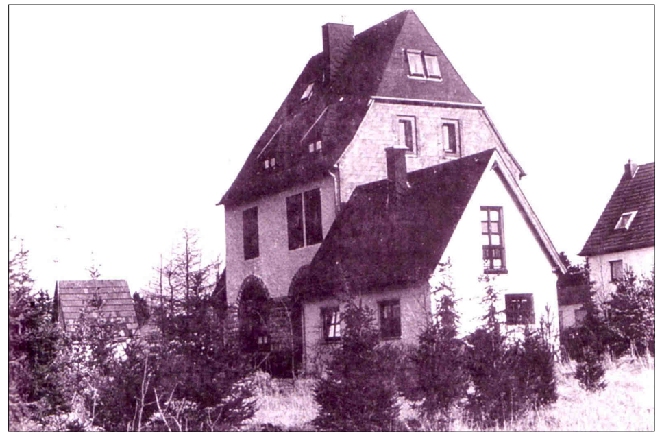
Unser Bahnhof, vom Bahnsteig aus gesehen.
