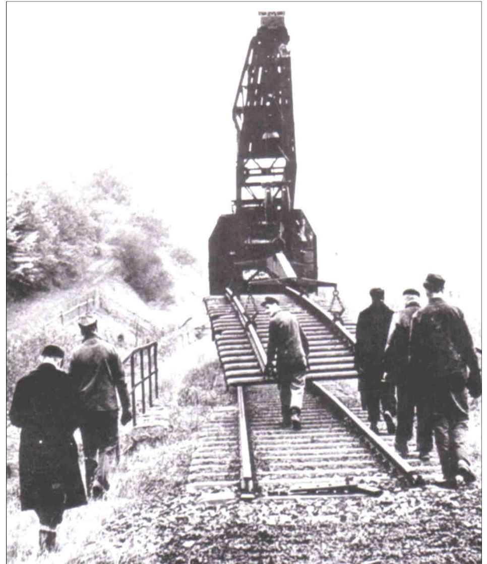
Der „Dörfer Jong“ Klemens Blens aus Mülheim packt beim Abbau der Gleise - hier gegenüber Hülchrath - kräftig an. (Leider ist das Foto aus Kemp, Ahrtalbahnen, sehr undeutlich.)
