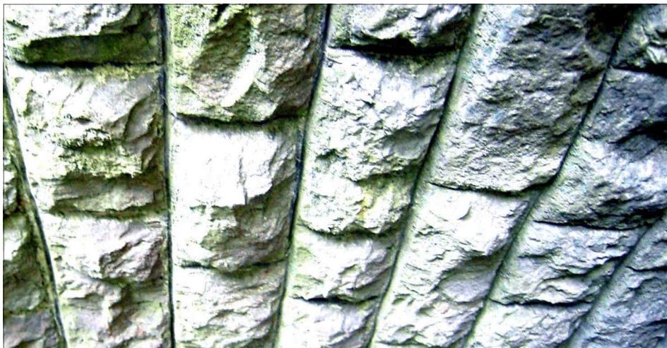
Unterführung am Altenburger Weg - Decke
